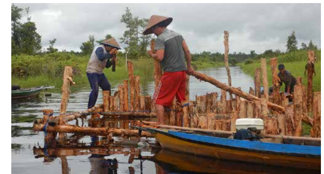
102 Entwässerungskanäle wurden bereits blockiert
